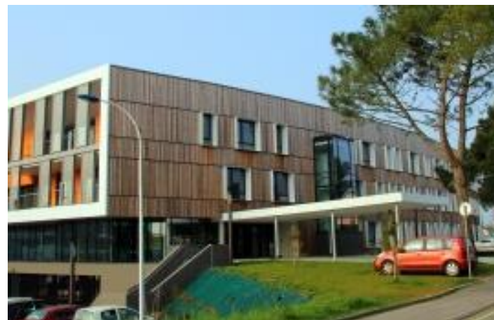
Siège de la CCPR et antenne Pole Emploi
